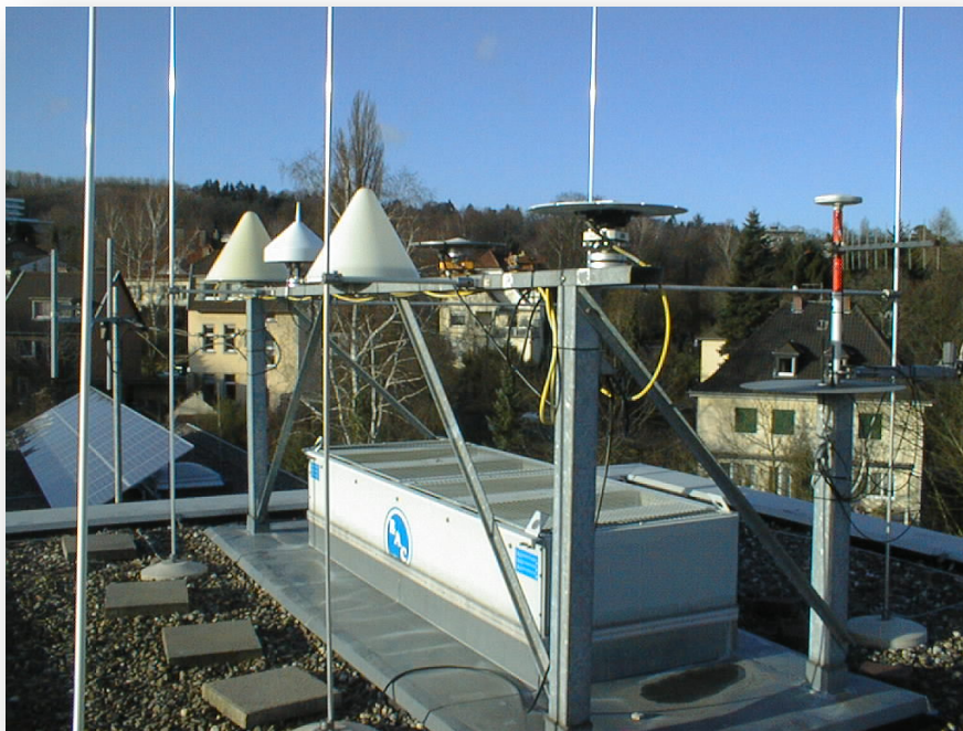
12/2000 - Stahlträger mit Referenzantenne (links) und Prüfling (rechts)
