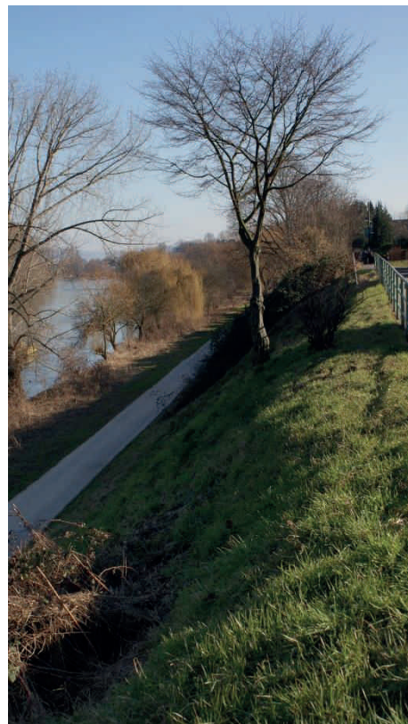
Bild 3-16: links: übersteile Böschung, Rhein-km ~663,3 rechts: Anrisse, Rhein-km ~662,1 (März 2013)
