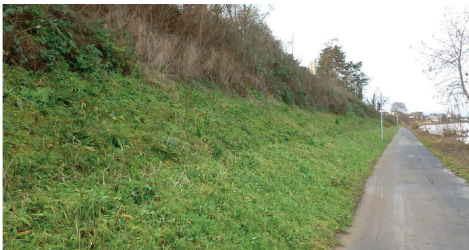
Bild 3-12: Wasserbausteine unter Grasdecke, im oberen Bereich Gehölzbewuchs, Rhein-km ~662,8 (Januar 2012)
