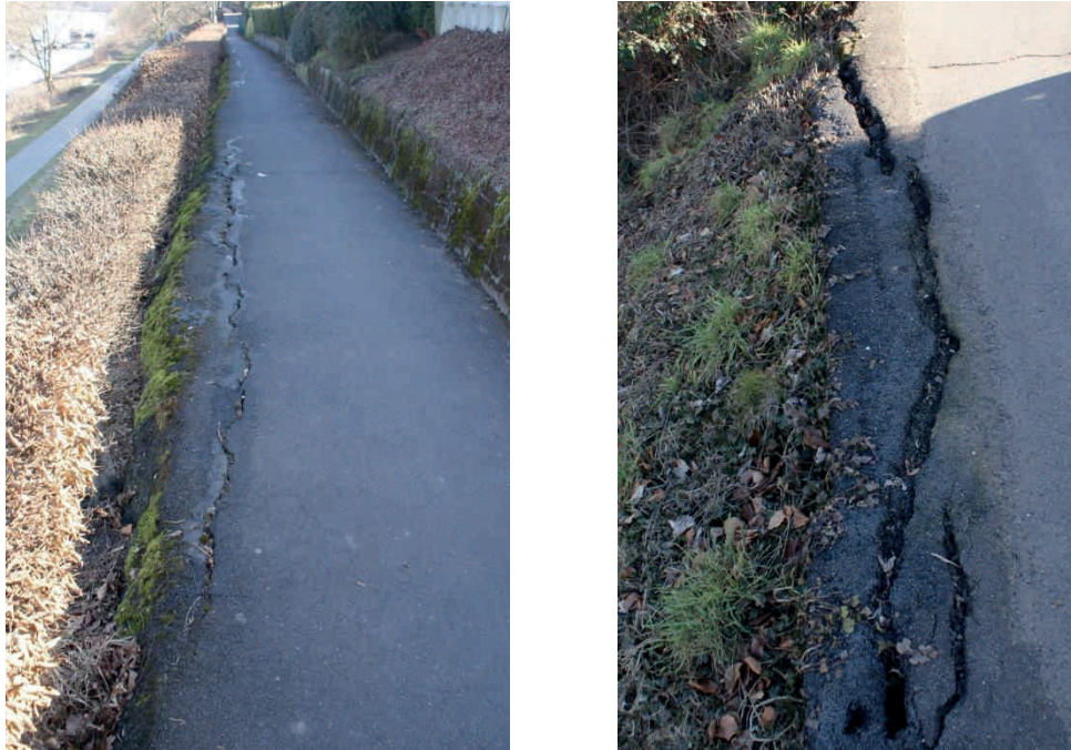
Bild 3-18: Längsrisse im Asphalt, links: Rhein-km ~662,6, rechts: Rhein-km ~662,0 (März 2013)
