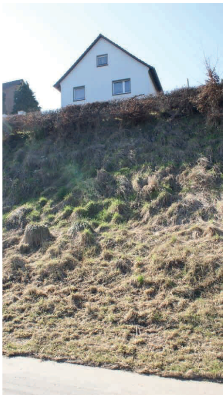
Bild 3-16: links: übersteile Böschung, Rhein-km ~663,3 rechts: Anrisse, Rhein-km ~662,1 (März 2013)
