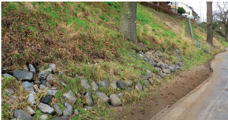
Bild 3-11: Lokale aufgebrachte Steinschüttung, Rhein-km ~662,6 (Januar 2012)
