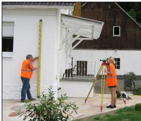
Höhenfestpunkte sind die Grundlage für sämtliche Höhenangaben im öffentlichen Leben. Sie dienen unter anderem der Höhenbestimmung bei Bauvorhaben, der Herstellung von Landkarten, dem Hochwasserschutz oder der Erkennung von Bodenbewegungen in Bergbaugebieten. Die Höhenmessungen werden bedarfsgemäß regional durchgeführt und regelmäßig wiederholt.
