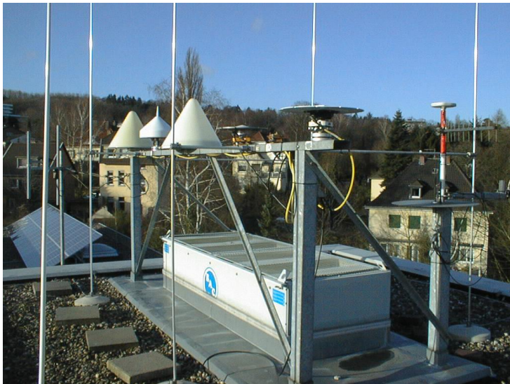
Stahlträger mit Referenzantenne (links) und Prüfling (rechts) beim LVermA NRW.
