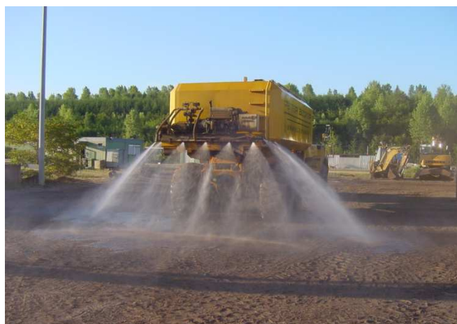
Abb. 5.3/7: Benetzung der unbefestigten Wege
