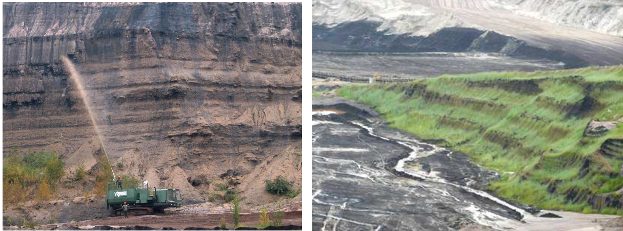
Abb. 5.3/15: Anspritzbegrünung auf längerlebigen Kohleböschungen
