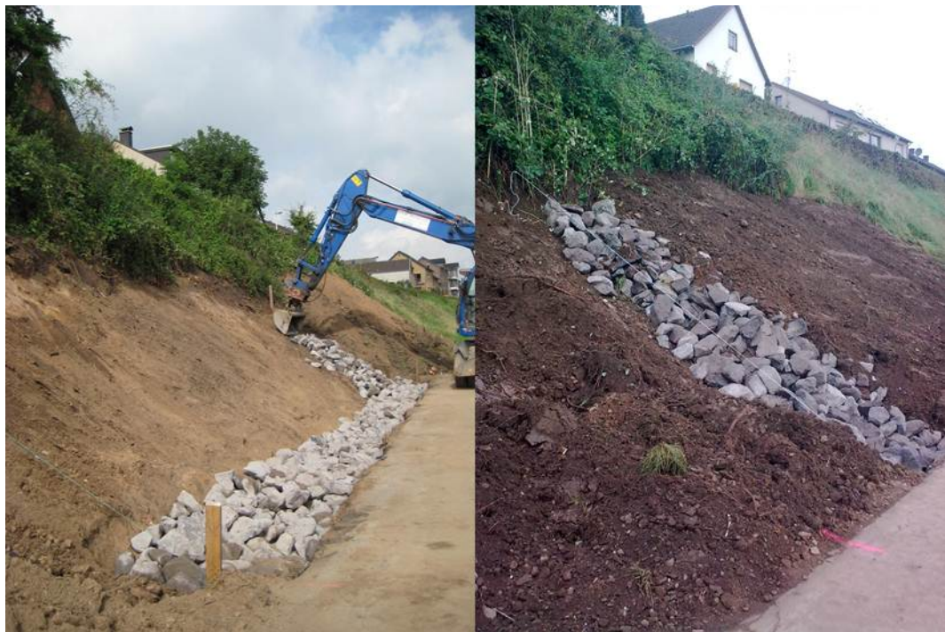
Bild 3-3: Vorläufigen Stabilisierung der Rheinuferböschung durch Wasserbausteine [3]
