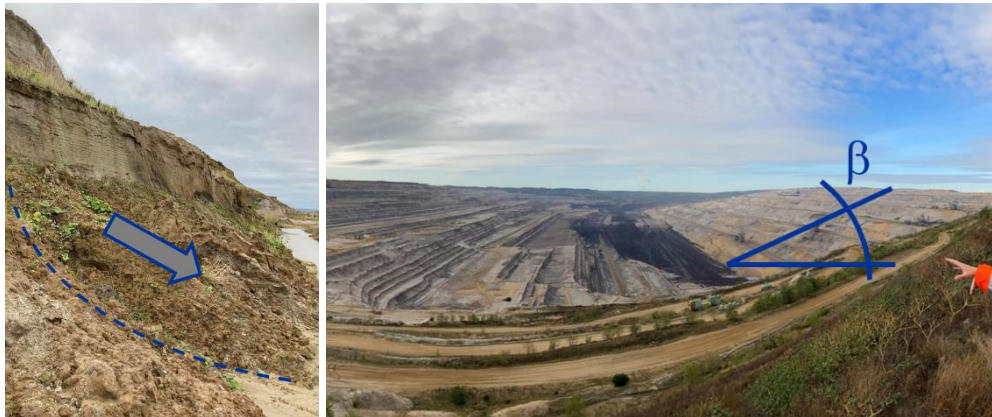
Abb. 16: Nicht dauerhaft standsichere Gewinnungsböschung links und bereits abgeflachte Innenkippe rechts (Quelle: Eigene Aufnahme ZAI)
