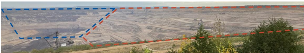
Abb. 27: Nordrandböschung (blau umrandet) und Gewinnungsböschung (rot umrandet) (Quelle: Eigene Aufnahme ZAI)
